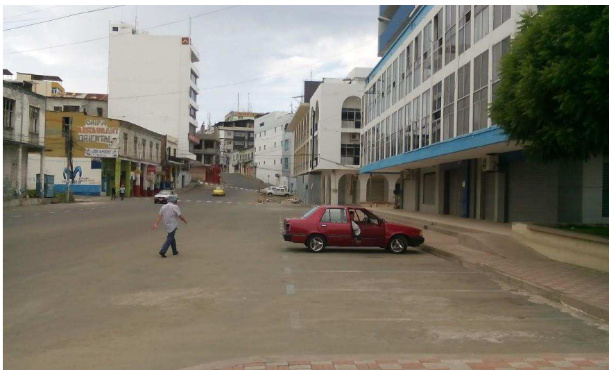
Foto 2 – Av. 4 edificio EPAM Fuente: Investigación de Campo Autor: Tesista
