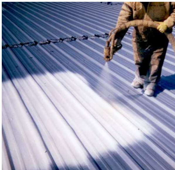
GRAFICO 97: Proyección de la espuma de Poliuretano en cubierta Fuente: Arquigrafico -Architecture, Engineering-Construction
