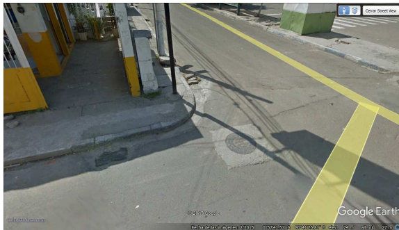
GRÁFICO 31: Visualización de la presencia de sistema de alcantarillado. Fuente: Google Earth, Investigador.
