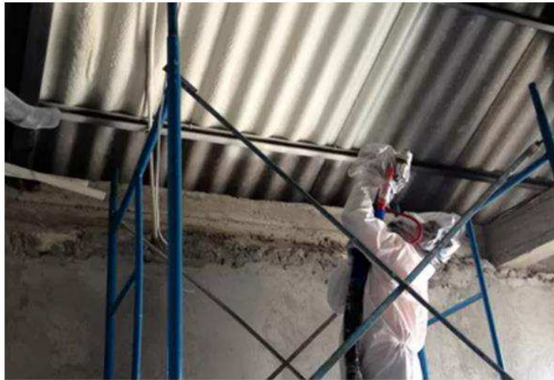
Imagen N°21 – Aplicación de espuma poliuretano. Fuente: Ecuapoliuretanos.
