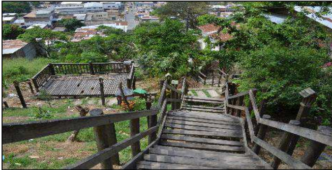
Escalinata en mal estado
