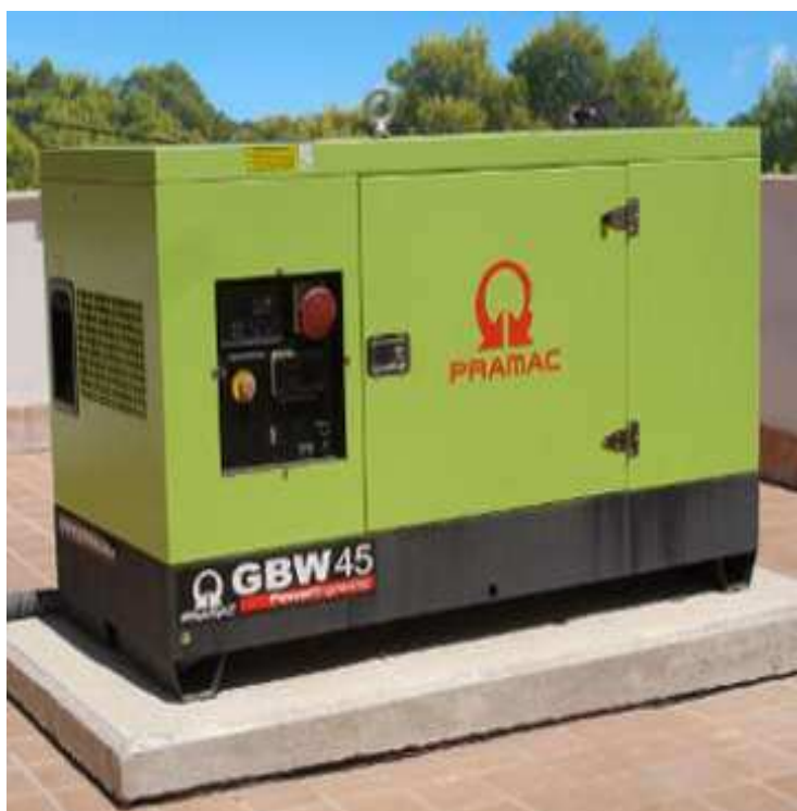
Figura nº10: Banca de Hormigón Flotante.
