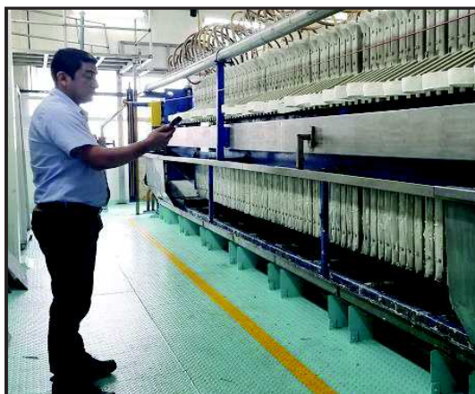
Figura 45. Medición de iluminación Fraccionamiento 2 Fuente: Auditoría energética
