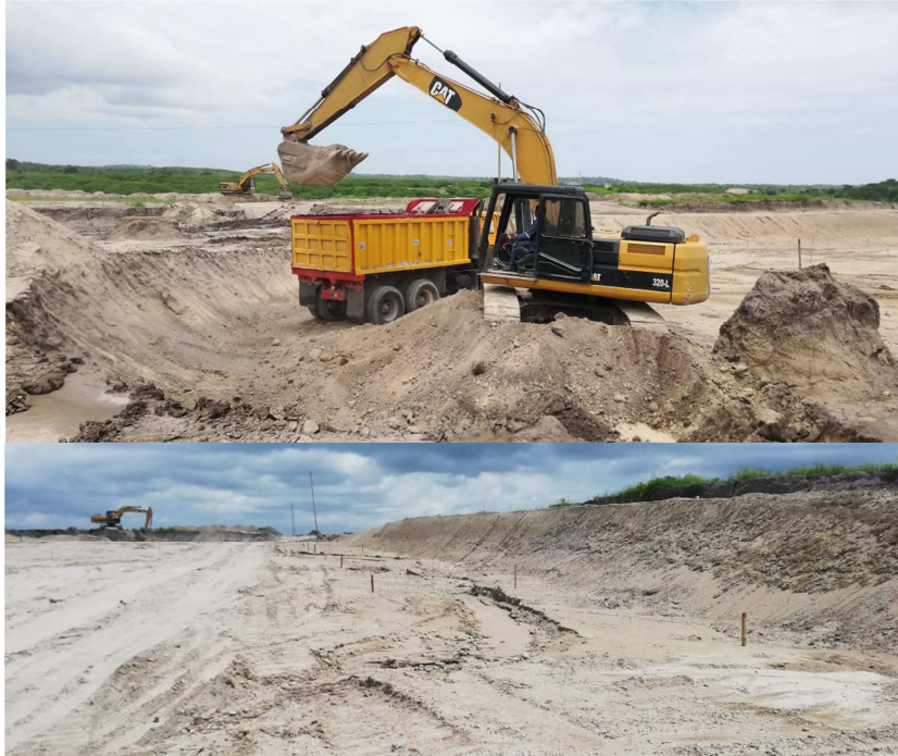
Trabajos de excavación y desalojo de capa vegetal para la construcción de proyecto urbanístico
