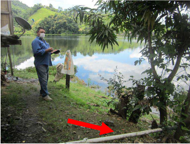
Desague de aguas residuales hacia la represa.
