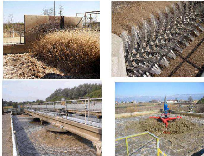
Figura 5. Aireadores superficiales tipo cepillo y tipo turbina (Guest, 2014)
