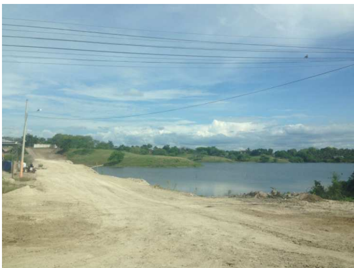
Imagen 5.- Realización de relleno en zona de riesgo.
