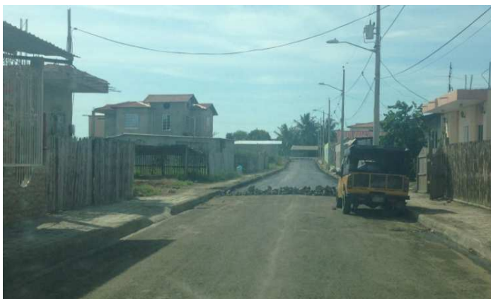
Imagen 19.- Asfaltado de vías locales.
