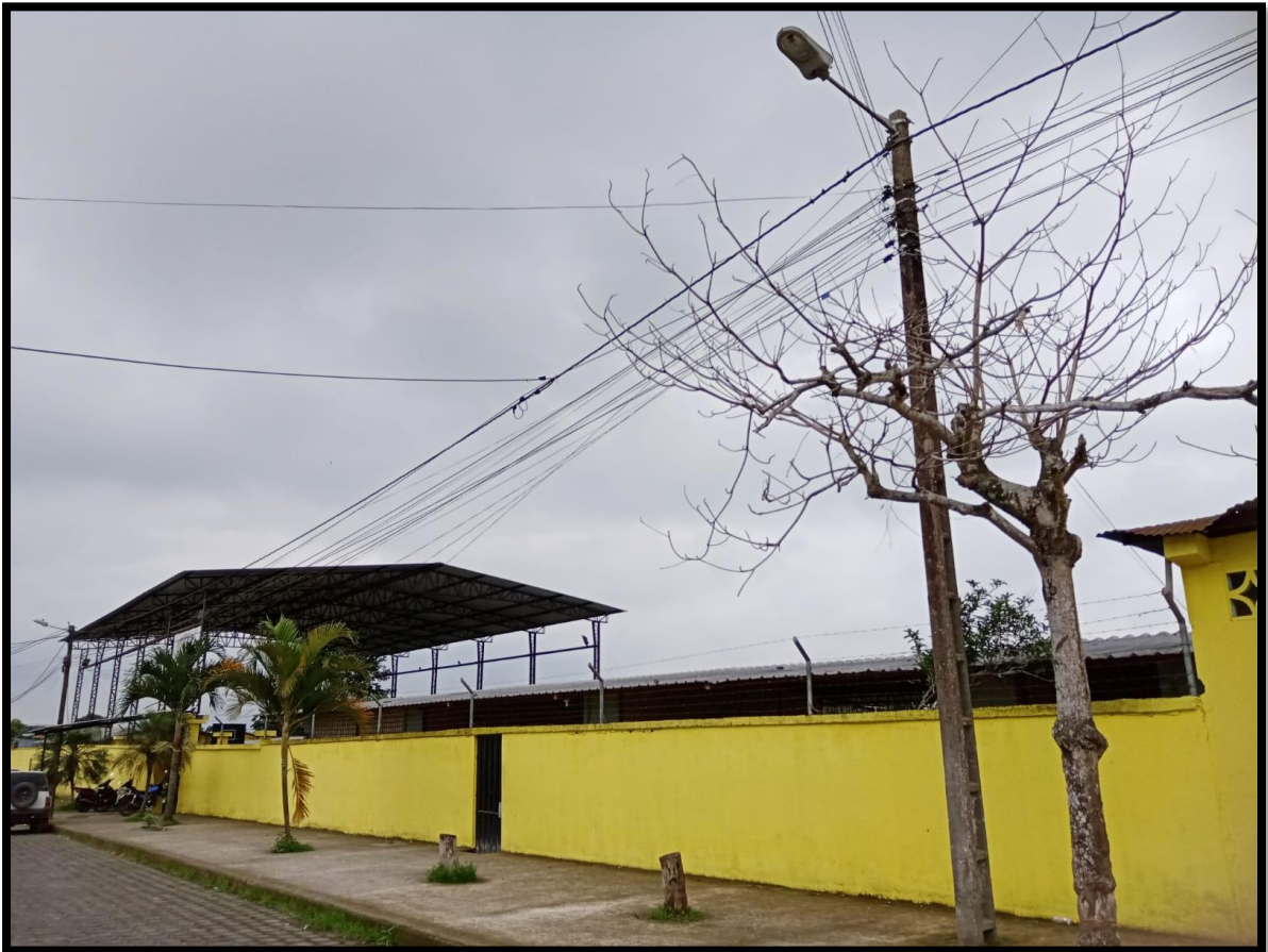
Ilustración 17 Falta de punto de acceso de la institución
