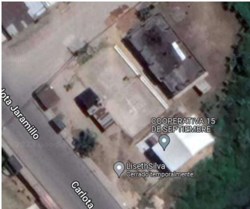
Ilustración 8 Vista aérea del Subcentro de salud "15 de Septiembre"
