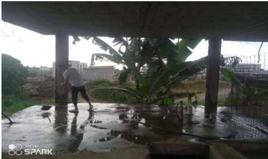
Anexo 13. Construcción de las unidades experimentales.
