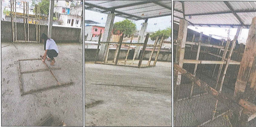
Construcción de jaulas para tratamientos
