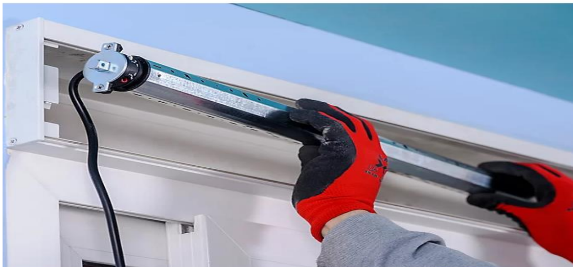
Ilustración 4 Coloca el motor ya instalado en el hueco del cajón
