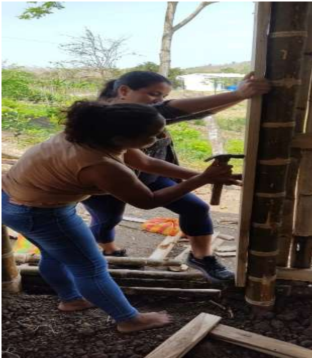
Anexo 4 Colocación de la puerta del galpón
