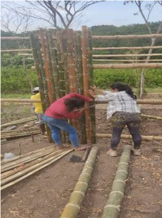
Anexo 2 Colocación de latillas alrededor del galpón
