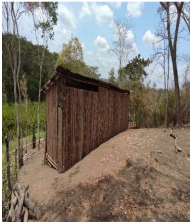
Anexo 5 Galpón completo con todas sus estructuras
