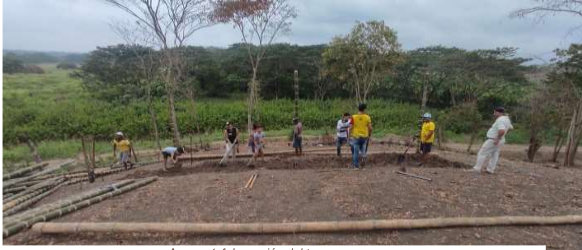
Anexo 1 Adecuación del terreno
