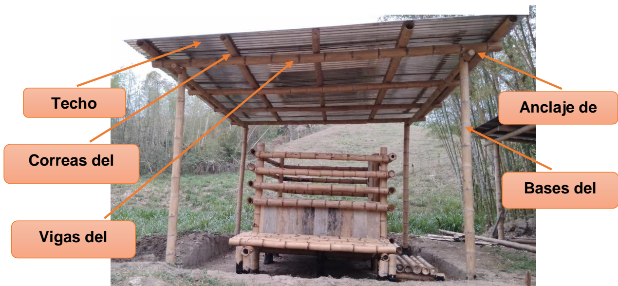
Ilustración 11. Construcción del techo
