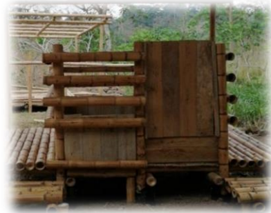
Ilustración 20. Colocación de la puerta
