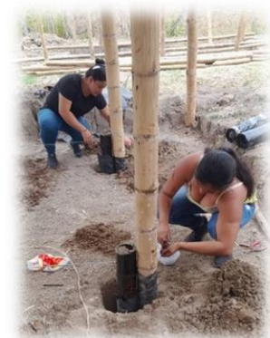
Ilustración 17. Fijación de la estructura
