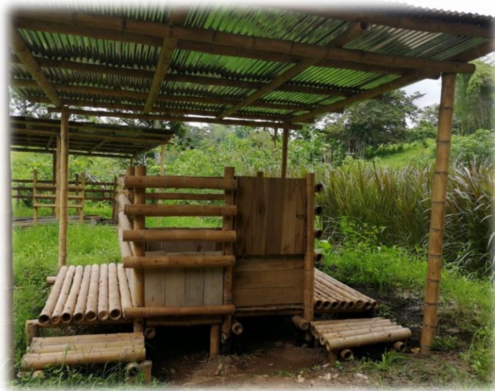
Ilustración 4. Galpón de la cama profunda aérea
