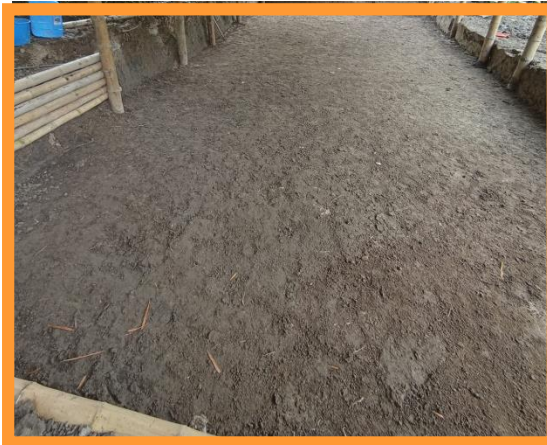
Ilustración 9 Nivelación del terreno
