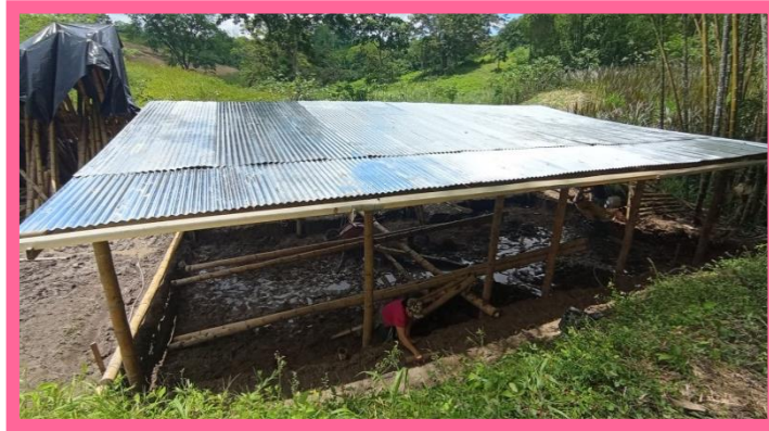
Ilustración 14 Colocación del techo
