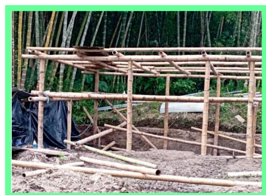
Ilustración 12 Colocación de los soportes del techo
