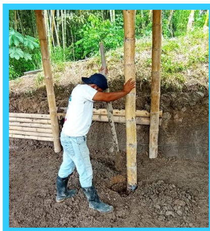
Ilustración 15 Colocación de los pilares
