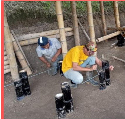
Ilustración 18 Fijación de la estructura
