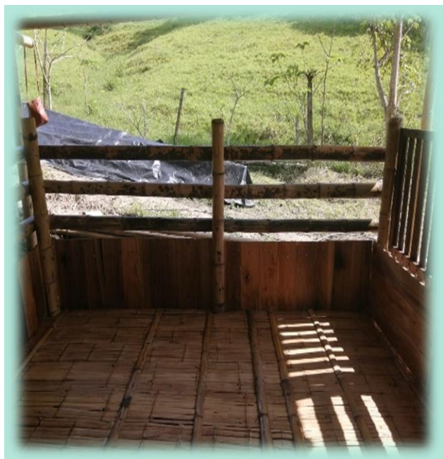
Ilustración 35. Cerramiento del galpón.
