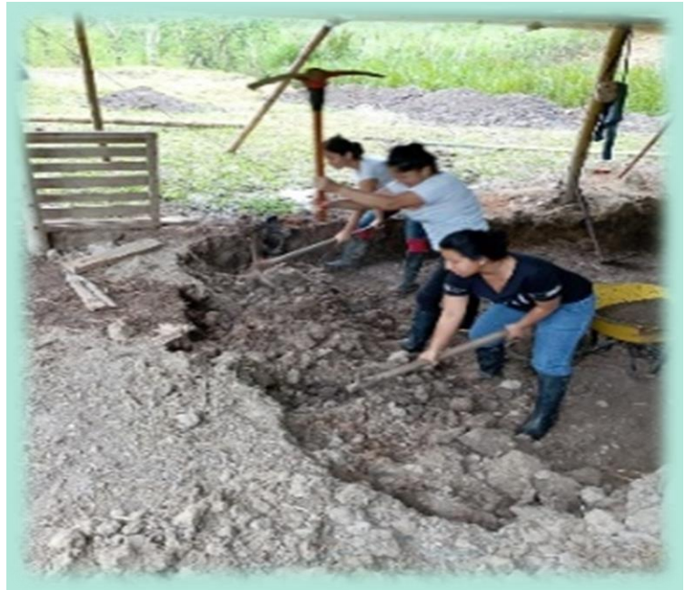
Ilustración 19. Nivelado del suelo
