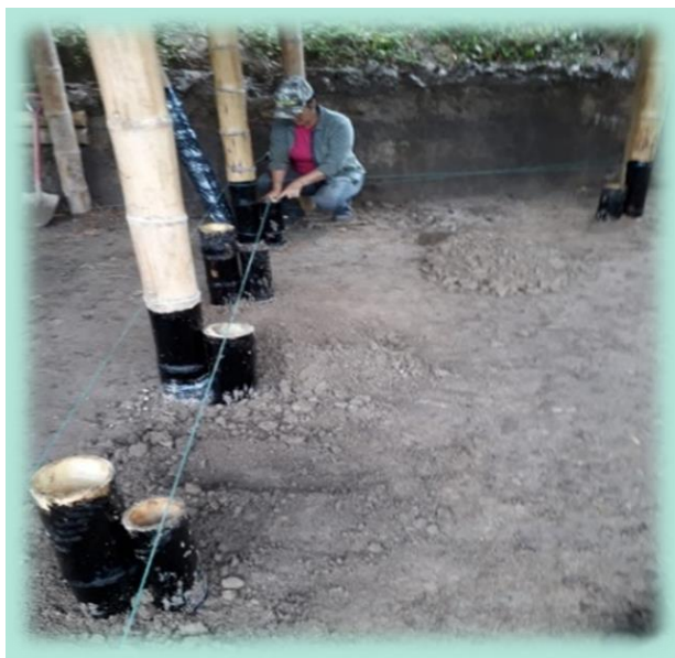
Ilustración 30. Fijación de la estructura.
