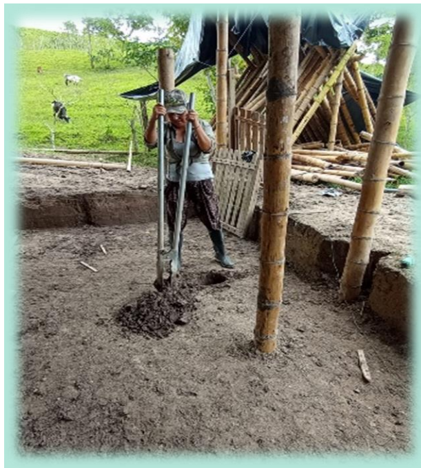
Ilustración 28. Hoyos para ubicar los pilares.
