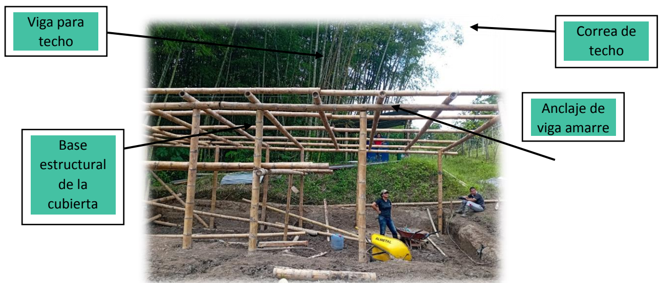
Ilustración 21. Construcción del galpón
