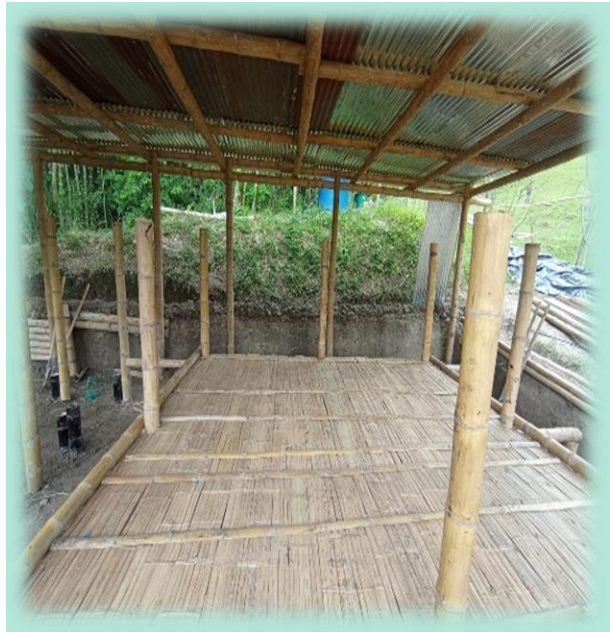
Ilustración 32. Piso de cama profunda aérea.
