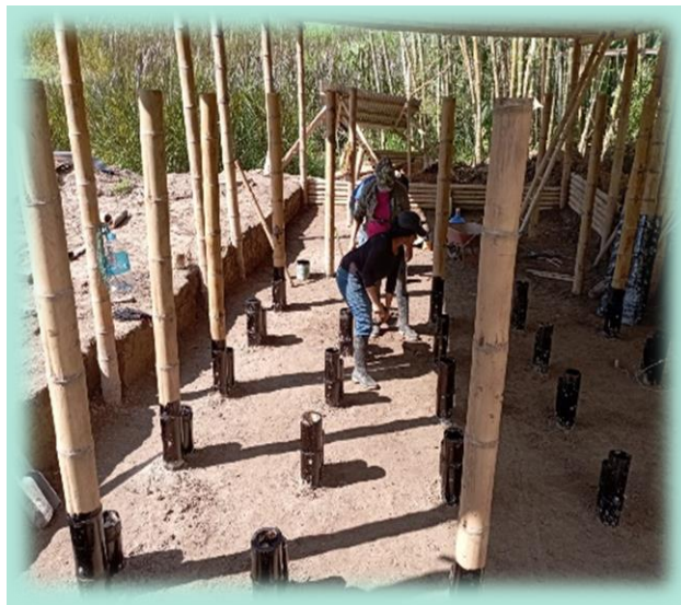
Ilustración 29. Colocación de los soportes.
