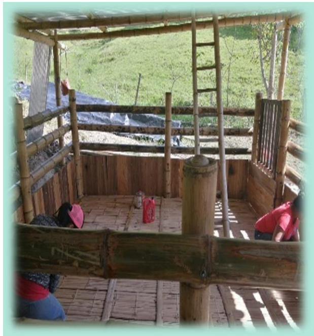
Ilustración 34. Cerramiento del galpón.
