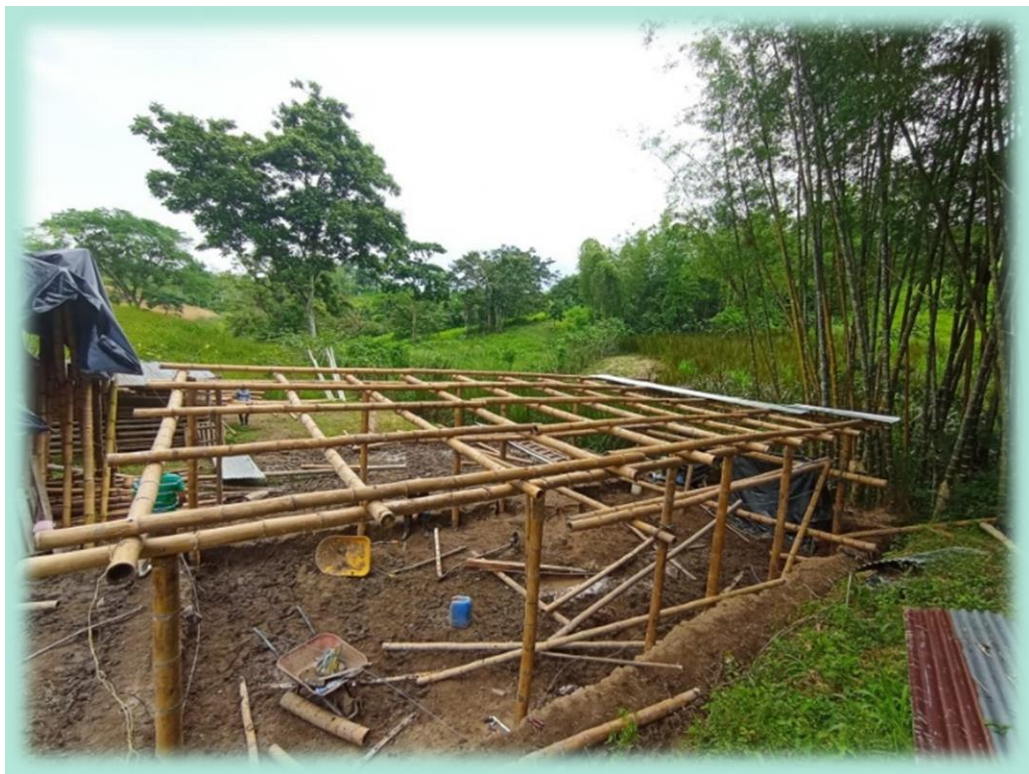
Ilustración 22. Estructura de la cubierta.
