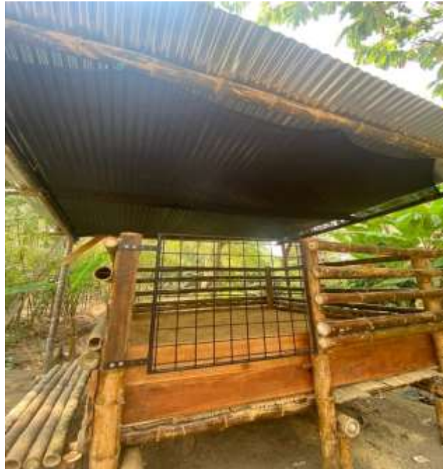
Anexo 2: infraestructura de sistema de cama profunda.
