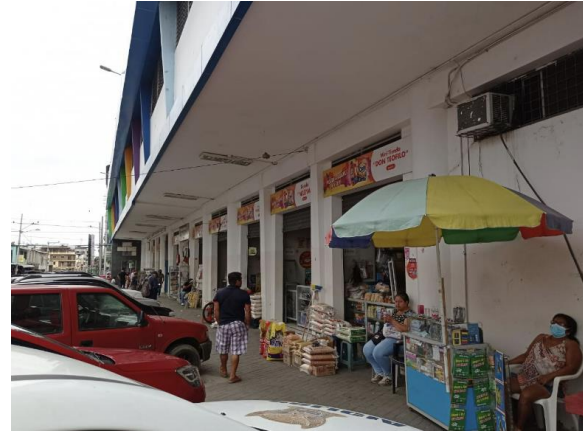
Figura 19. Mercado Central Municipal de Manta – locales comerciales del mercado.
