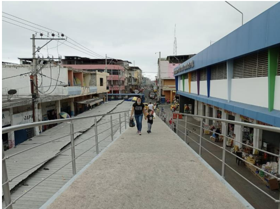
Figura 17. Mercado Central Municipal de Manta – rampa ubicada en la fachada lateral para ingreso a la planta alta.
