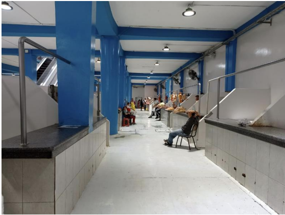
Figura 23. Mercado Central Municipal de Manta – puestos de venta en planta baja del mercado.
