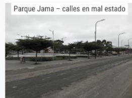
Parque Jama - calles en mal estado
