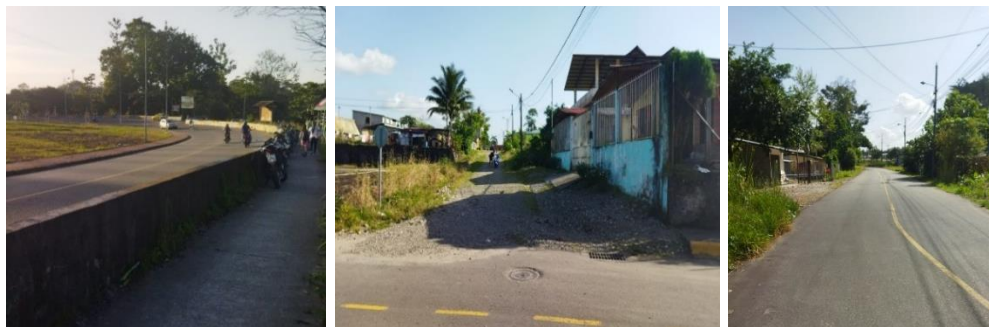
Ilustración 35: Evidencia fotografica del estado de las vías. Fuente: Elaborado por las autoras.
