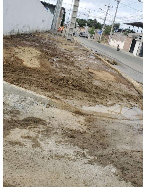
Figura 19: Se presentan aceras en construcción. Elaboración: Elaboración propia (R. Cedeño)
