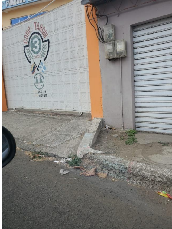
Figura 18: Obstáculos fijo de muro en acera. Elaboración: Elaboración propia (R. Cedeño)
