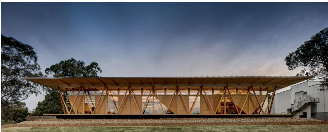
Ilustración 15 – Fachada principal del proyecto Fuente: Plataforma Arquitectura
