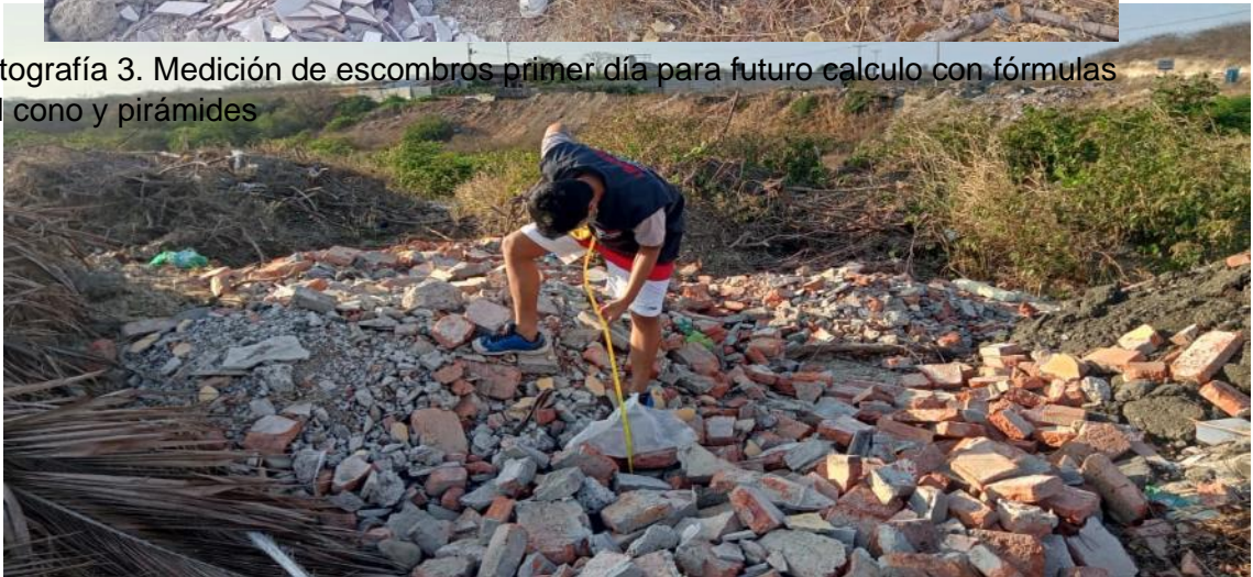
Fotografía 4. Medición de escombros día 2 de altura y base.
