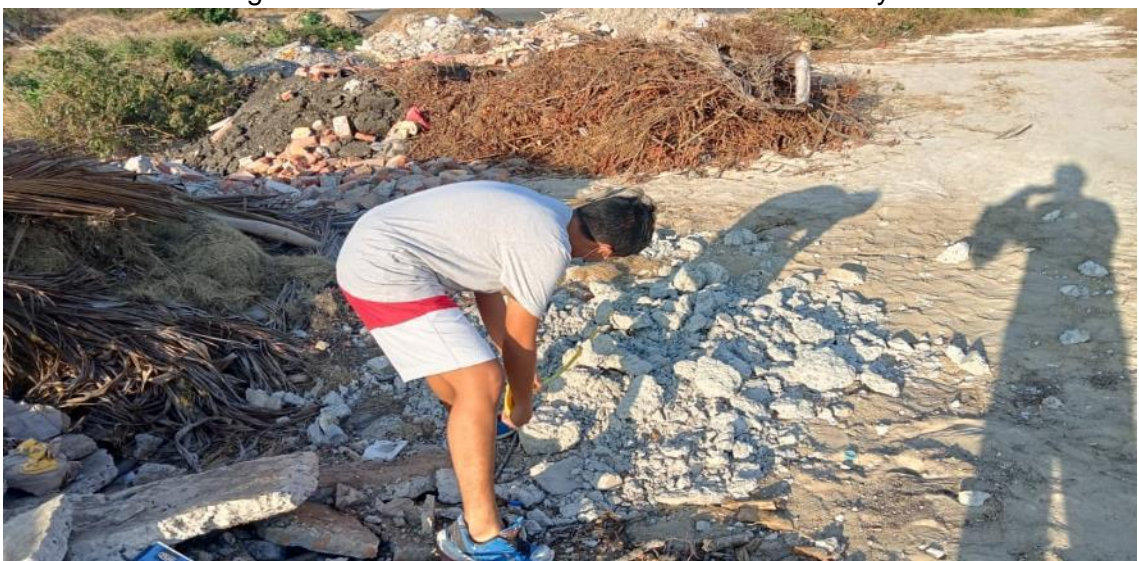
Fotografía5. Medición de escombros día 3 de altura y base
