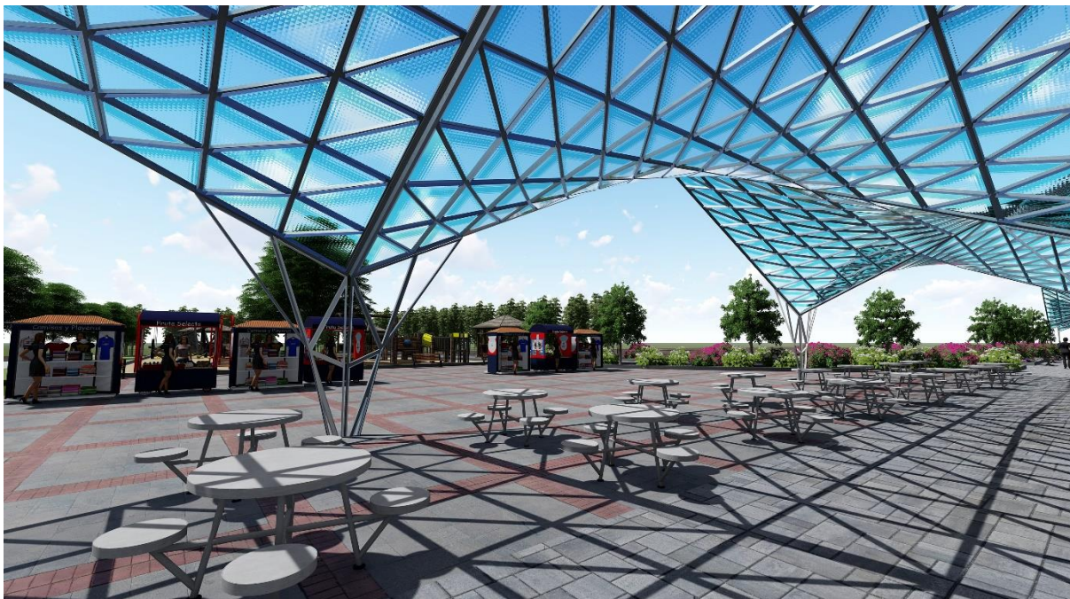
FIGURA No. 25. Vista de Estructura ubicada en Comedores.
