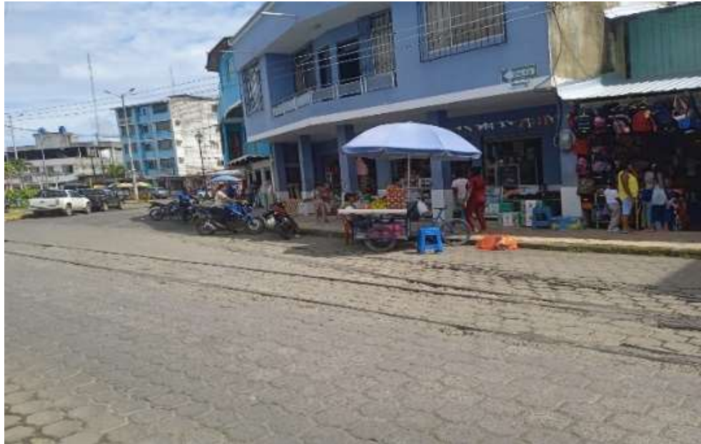
Imagen N.º 42: Estado de la calzada
