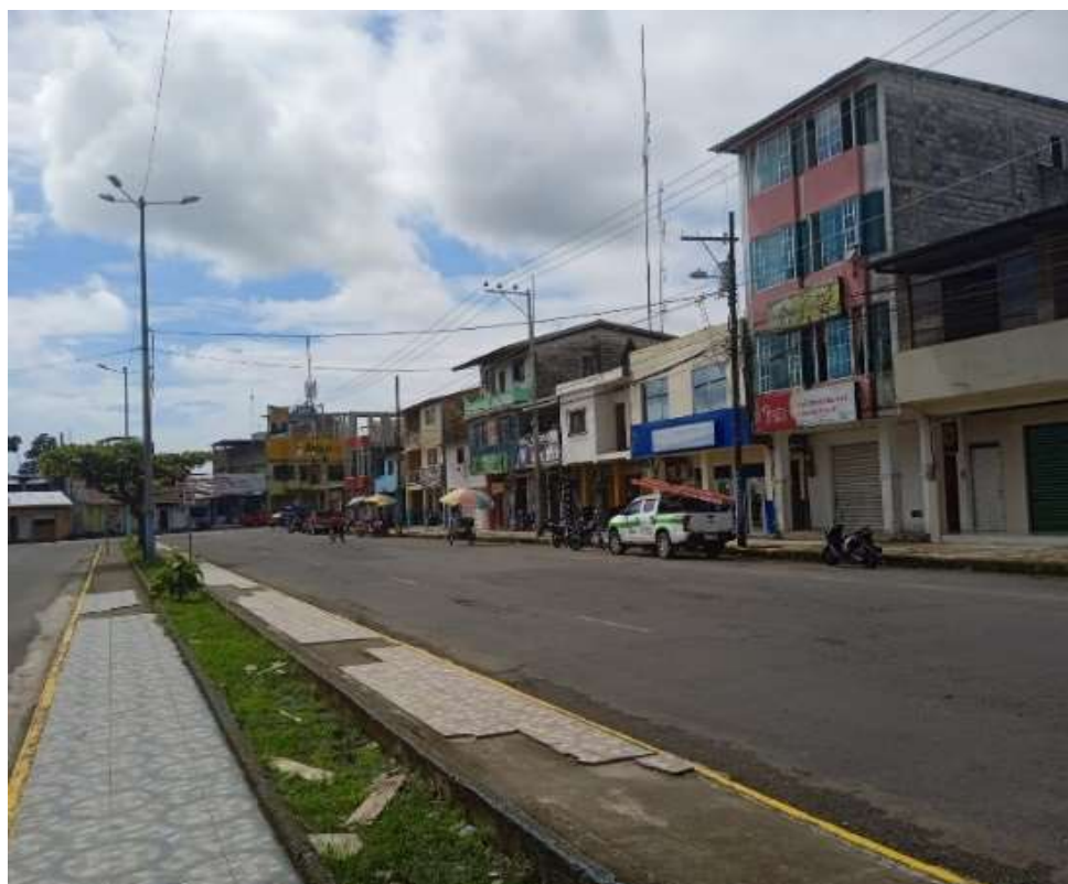
Imagen N.º 33: Estado de parterres y calzada.
