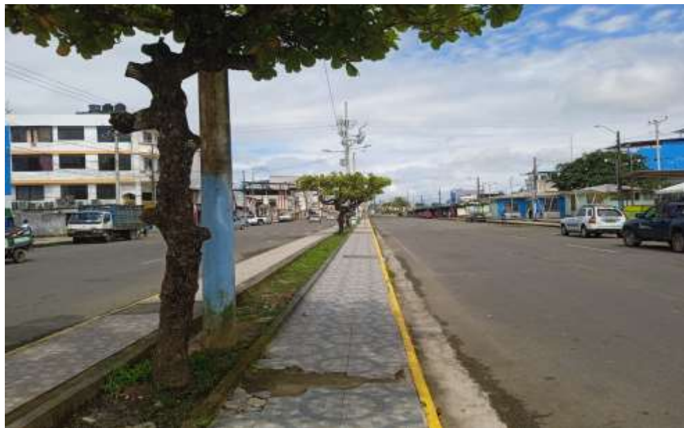
Imagen N.º 30: Estado de parterres y calzada
