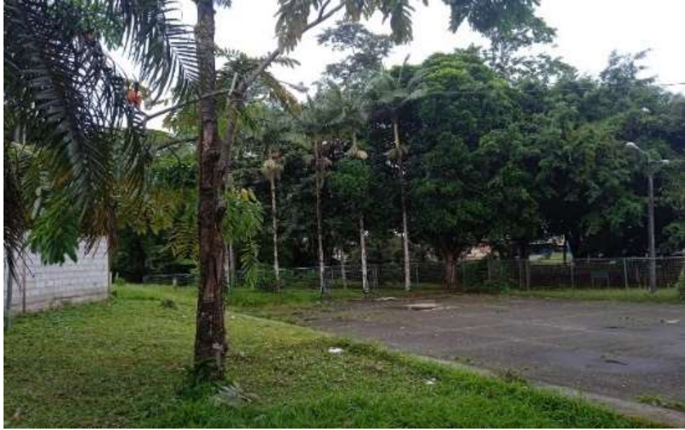
Imagen N.º 58: Cancha deteriorada
