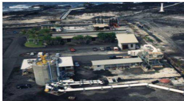
Figura 16. 210 kW Planta Experimental OC-OTEC (1993-1998) Fuente (Vega L. A., 1999)
