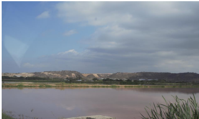
Ilustración 34 Estado actual de las lagunas de Oxidación. Elaboración propia
