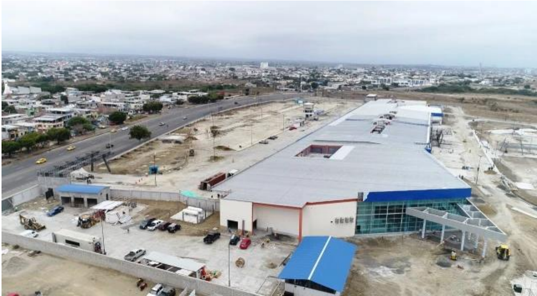
Ilustración 3 Vista aérea del actual terminal terrestre de Manta en construcción.
