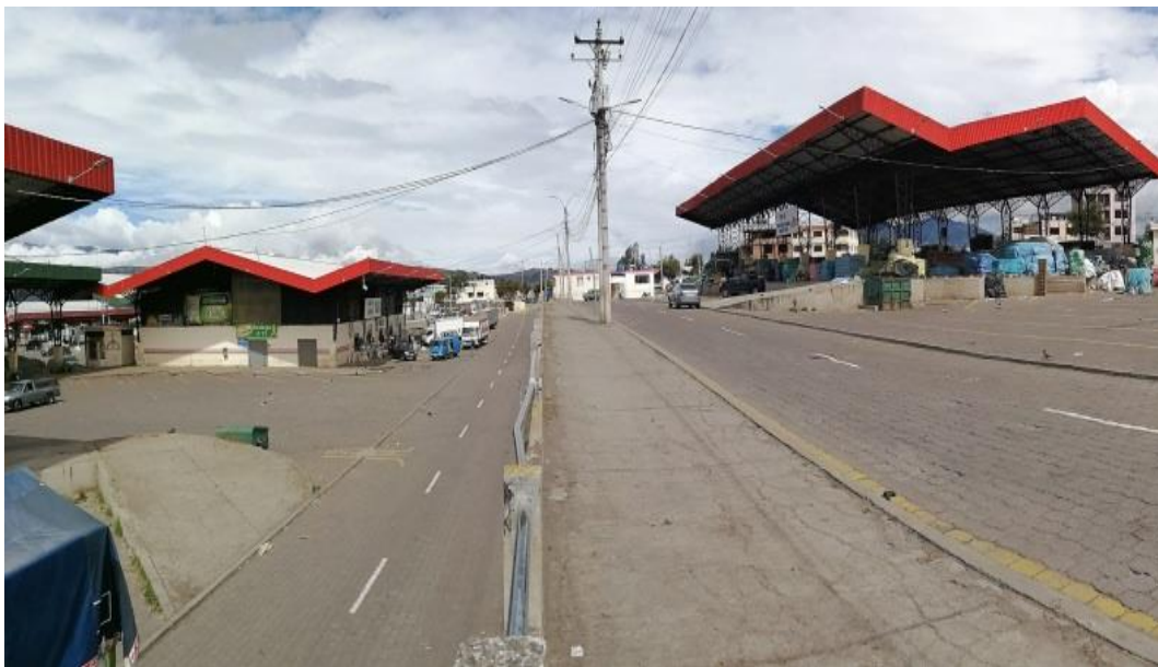
Ilustración 12, vista exterior, Mercado Mayorista de Ambato.
