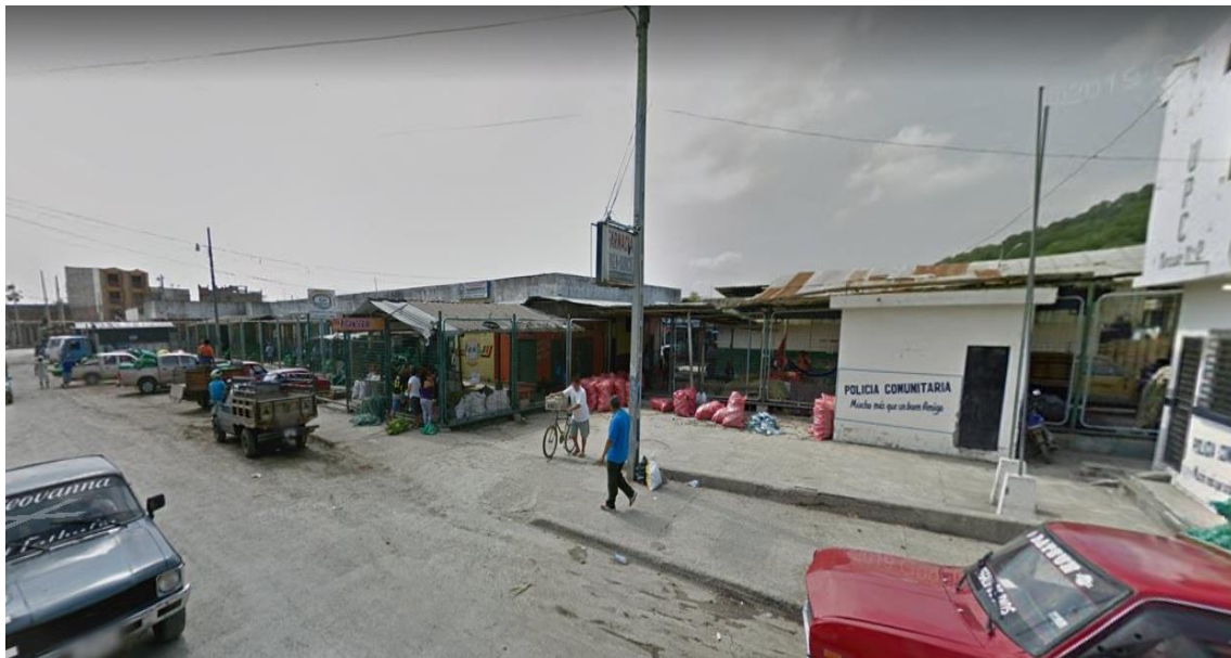
Ilustración 45, Exteriores del mercado N° 2 de Portoviejo, calle Francisco P. Moreira.
