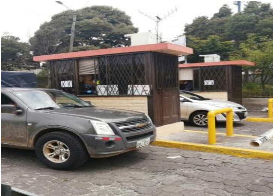
Ilustración 15, vista del ingreso, Mercado Mayorista de Ambato.
