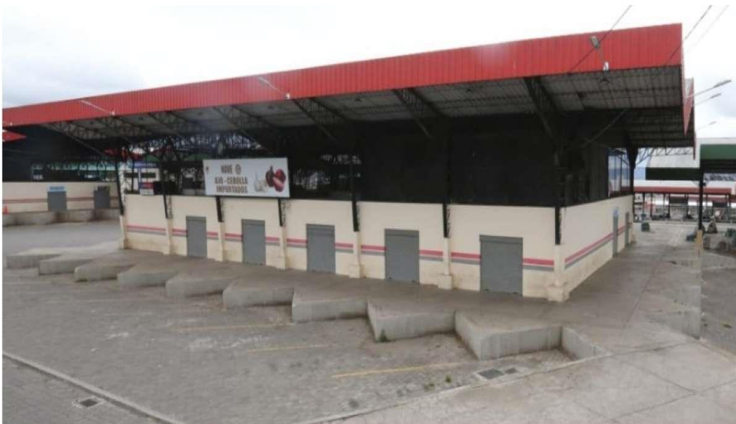
Ilustración 21, vista externa, Mercado Mayorista de Ambato.
