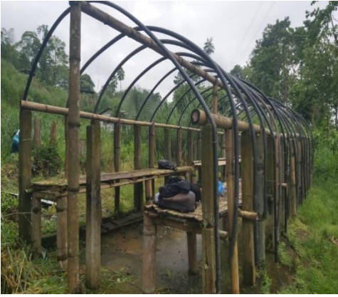
Anexo 20: Construcción de Cámara Térmica
