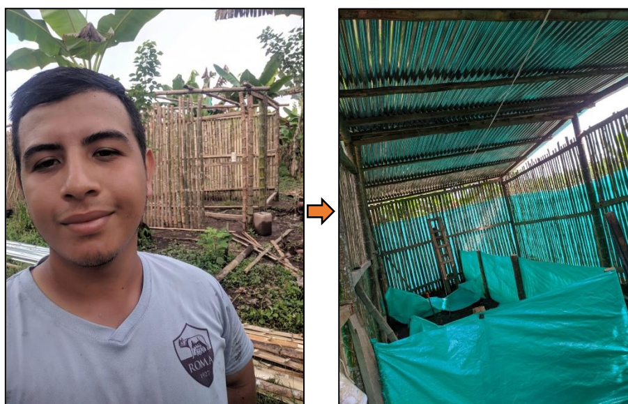
Construcción de galpón
