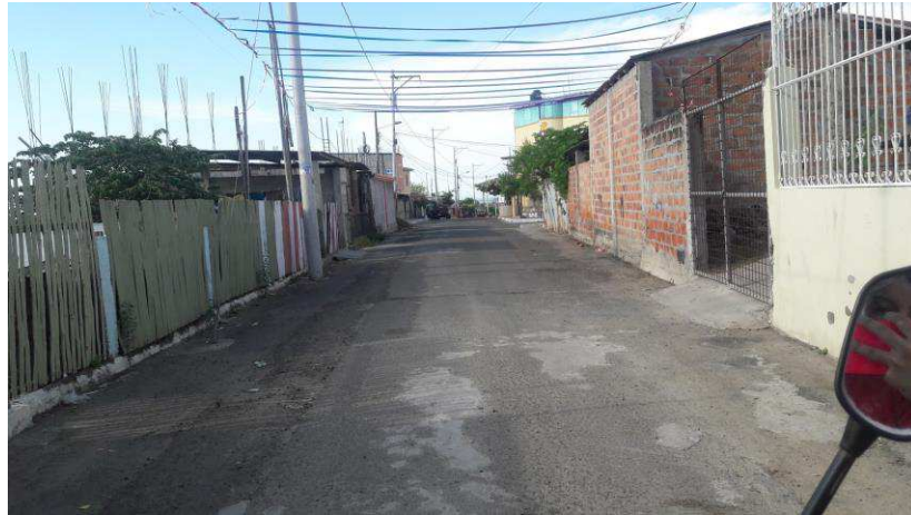
Barrio “2 de agosto”- Calle sin nombre que no presenta aceras para la circulación peatonal.
