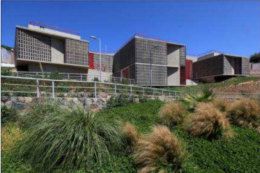
Ilustración 6 Implementación de equipamiento, Barrio 17 de Septiembre- Chile
