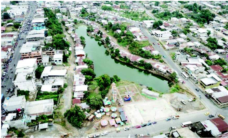
Ilustración 61: Estado actual del sector la Laguna Central Fuente: Fotos dron por tesista
