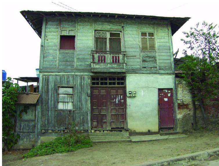
Figura 7: Inmueble patrimonial en el cantón Arenillas.
