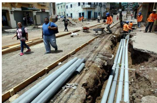
Imagen 1. Soterramiento de Cables
