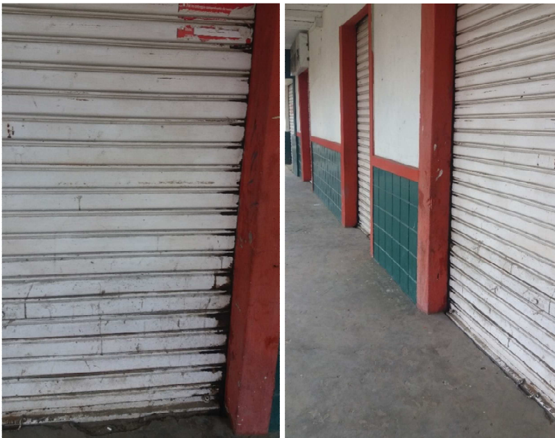
Anexo # 13 Vivienda Ramon de la Cruz, Fachada de la primera planta
