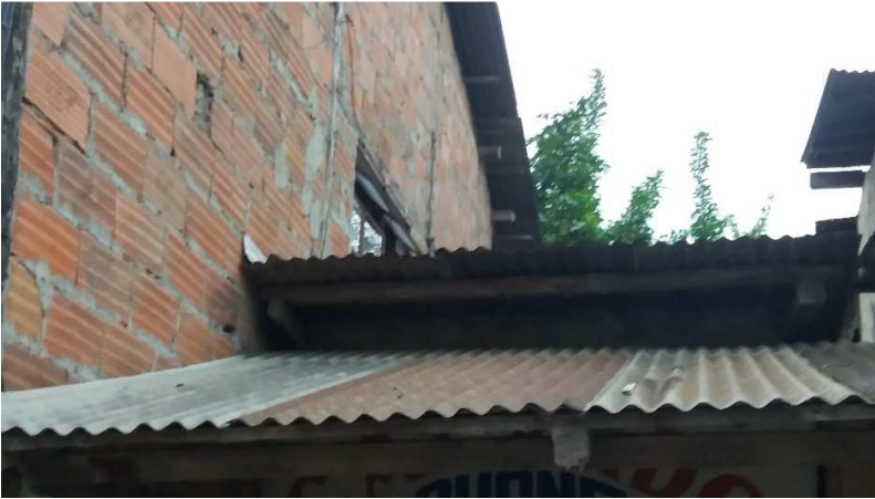
Anexo # 8 Vivienda Marlon Zambrano, fachada lateral
