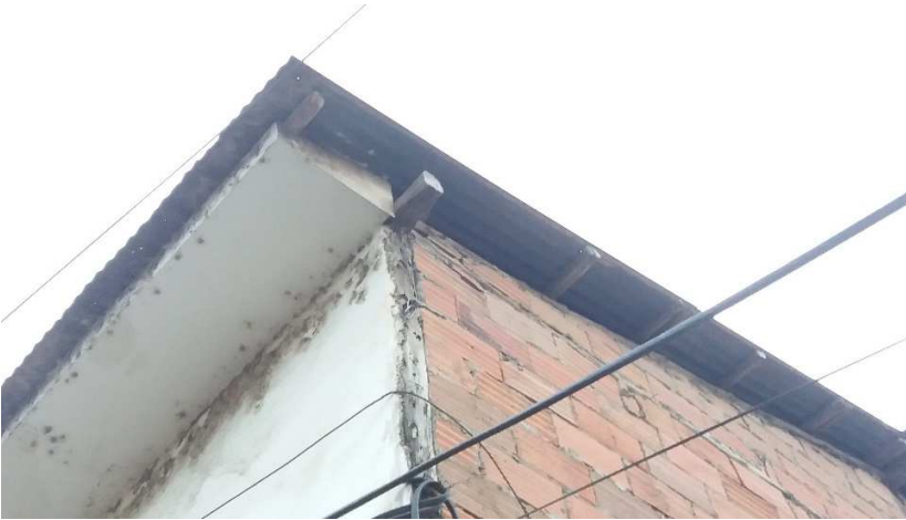
Anexo # 9 Vivienda Marlon Zambrano, cubierta
