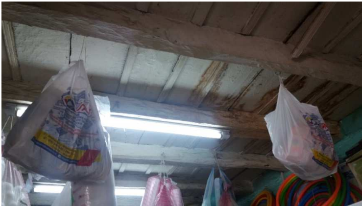
Anexo # 3 Vivienda Carlos Colamarco, bodega de la imprenta en planta baja
