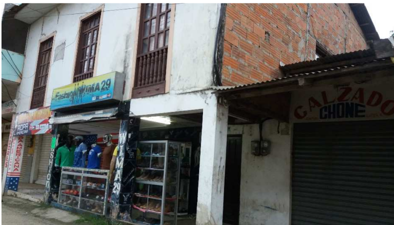
Anexo # 6 Vivienda Marlon Zambrano, fachada
