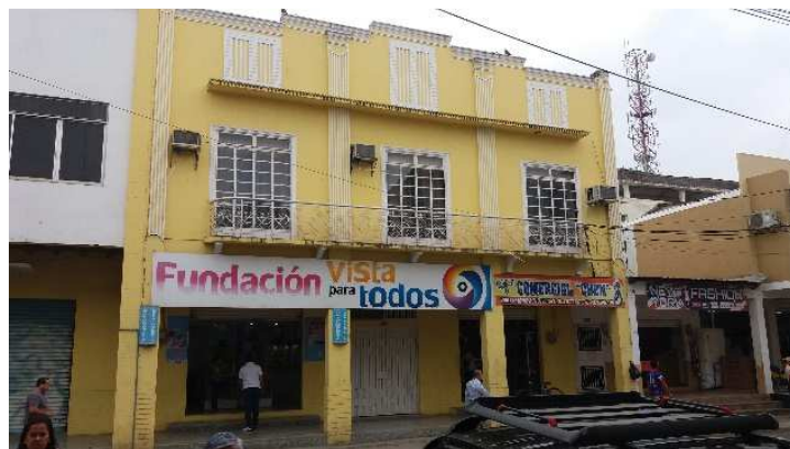
Gráfico # 12: Fachada de la vivienda "Herederos Herrera Miranda"
