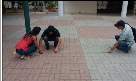
Ilustración 11: Replanteo del proyecto.
