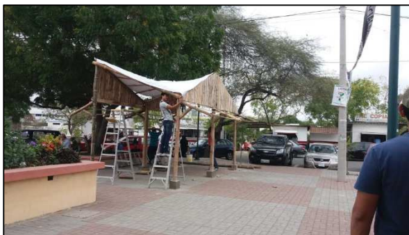
Ilustración 24: Colocación de lona central. Fuente: Investigación propia.
