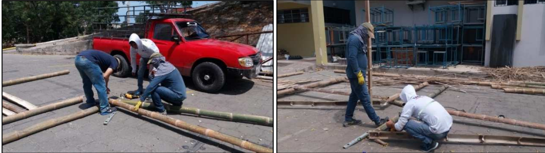
Ilustración 14: Armado de módulo.
