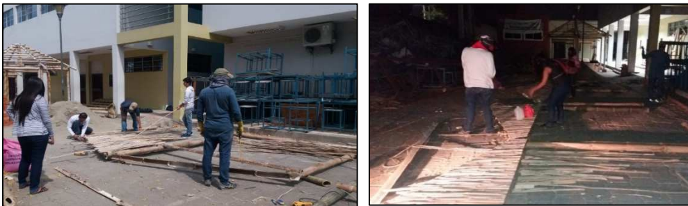
Ilustración 15: Colocación de latillas en fachadas.
