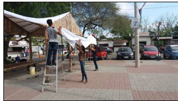
Ilustración 26: Colocación de aleros. Fuente: Investigación propia.
