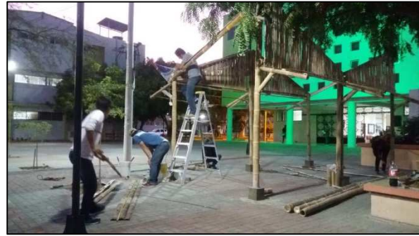
Ilustración 23: Colocación de correas para cubierta de lona. Fuente: Investigación propia.
