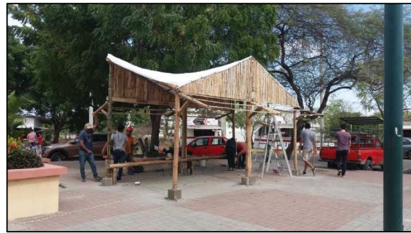
Ilustración 25: Colocación de asientos. Fuente: Investigación propia.
