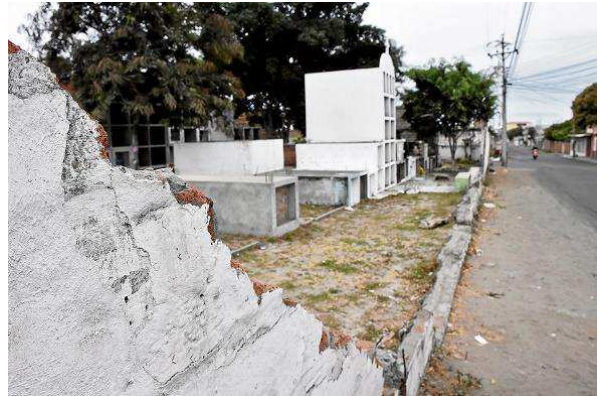
Ilustración 47. Cerramiento De Cementerio De Marbella Fuente: Autor de Tesis Elaborado por: Autor de Tesis
