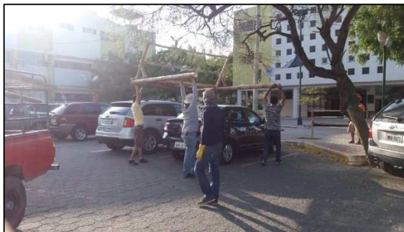
Ilustración 17: Transporte de módulos.
