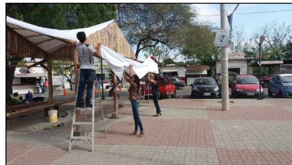
Ilustración 26: Colocación de aleros. Fuente: Investigación propia.
