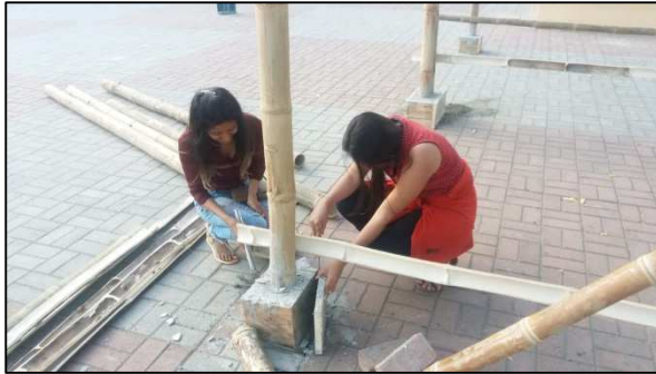
Ilustración 21: Desencofrado. Fuente: Investigación propia.
