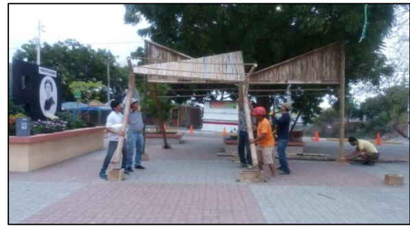
Ilustración 18: Colocación de módulos.
