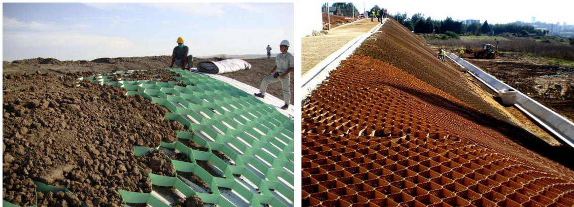
Figura 14. Imágenes de la aplicación del sistema geo-celular en una ladera
