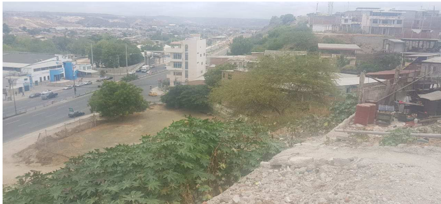
Anexo fotográfico 2. Vista de la parte alta de la ladera avenida 18.
