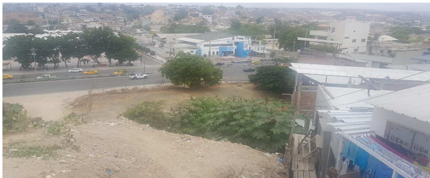
Anexo fotográfico 3. Vista de los asentamientos en la pendiente de la ladera
