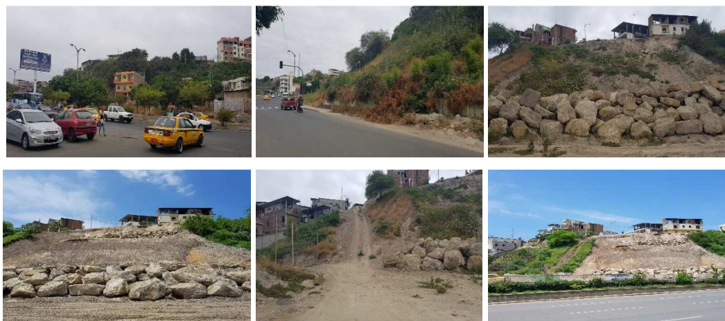
Figura 7. Imágenes de la situación actual de las laderas de la Avenida de la Cultura, en el tramo comprendido entre la Avenida 24 de Mayo y la avenida 19 de la Ciudad de Manta.
