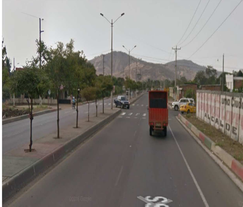
Ilustración 20: Autopista Manabí Guillem, estado actual de la vía.
