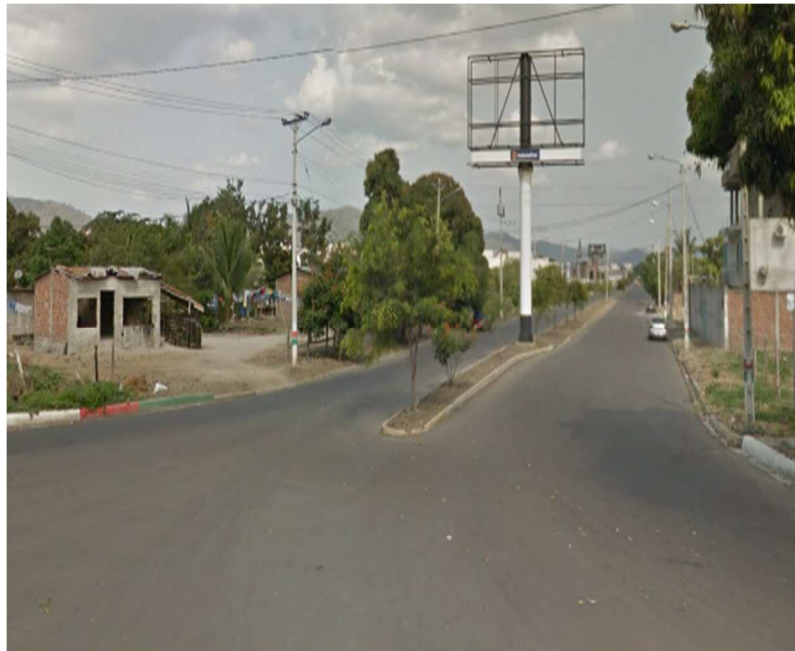
Ilustración 19: Avenida reales tamarindo, estado actual de la vía.
