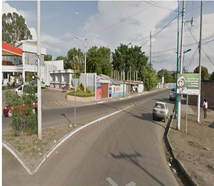
Ilustración 22: Calle 5 de junio, estado actual de la vía.
