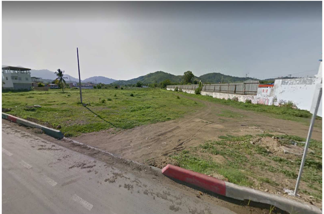
Ilustración 32 Bypass altura Cámara de Comercio
