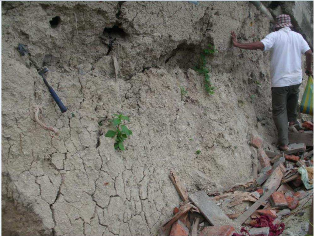
Fig. 21.- Afloramiento de coluvial en el escarpe del deslizamiento principal. Fuente: Estudio de suelo y alternativas de obras de mitigación.
