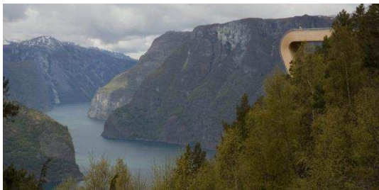
Fig.11.- Vista panorámica mirador. Fuente: (CAE, 2018)
