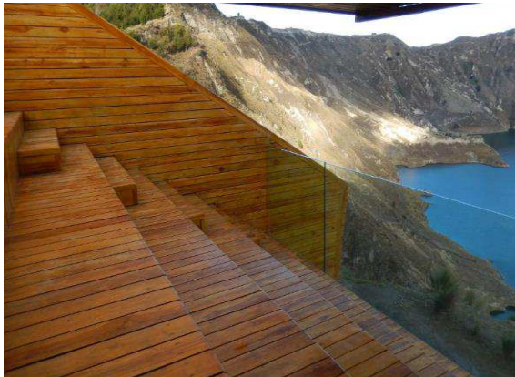
Fig.6.- Vista panorámica mirador. Fuente: (CAE, 2018)
