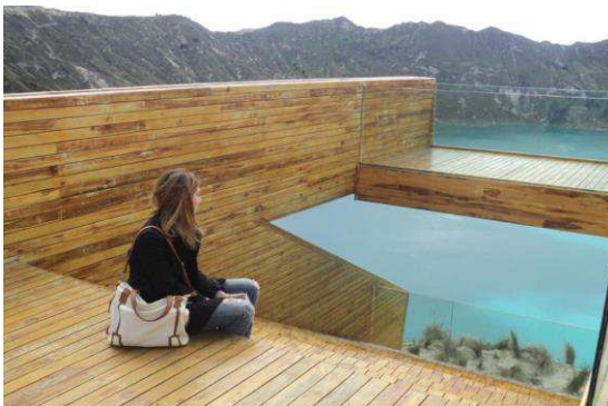
Fig.5.- Vista panorámica mirador. Fuente: (CAE, 2018).
