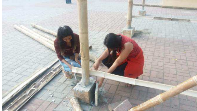
Figura 27: Desencofrado. Fuente: Elaboración propia.
