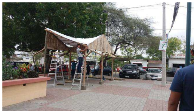
Figura 29: Colocación de lona central Fuente: Elaboración propia.
