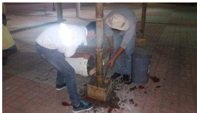
Figura 26: Fundido de módulos. Fuente: Elaboración propia.
