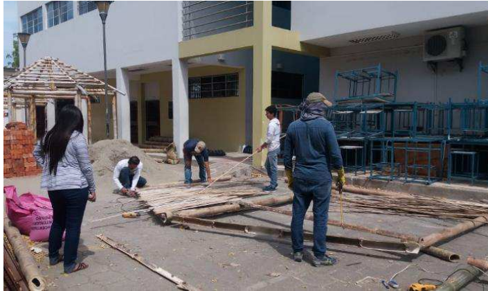
Figura 22: Colocación de latillas en fachadas.
