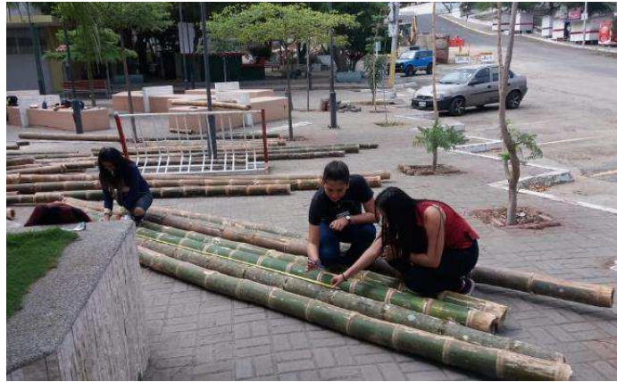
Figura 20: Selección y medición de la caña. Fuente: Elaboración propia.
