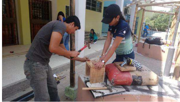
Figura 24: Armado de encofrado Fuente: Elaboración propia.
