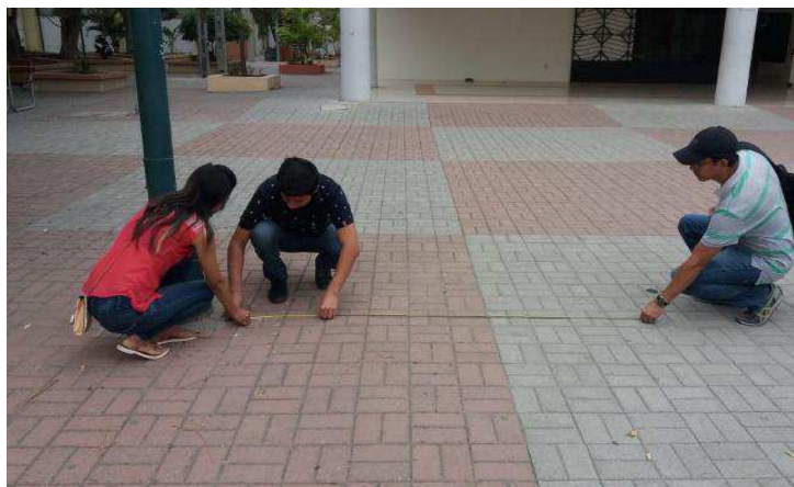
Figura 19: Replanteo del proyecto Fuente: Elaboración propia.
