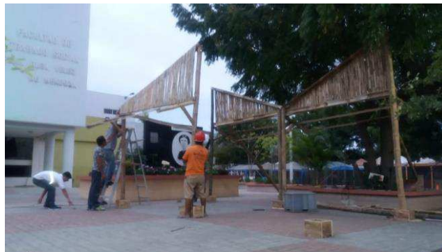
Figura 25: Aplomado de módulos Fuente: Elaboración propia.
