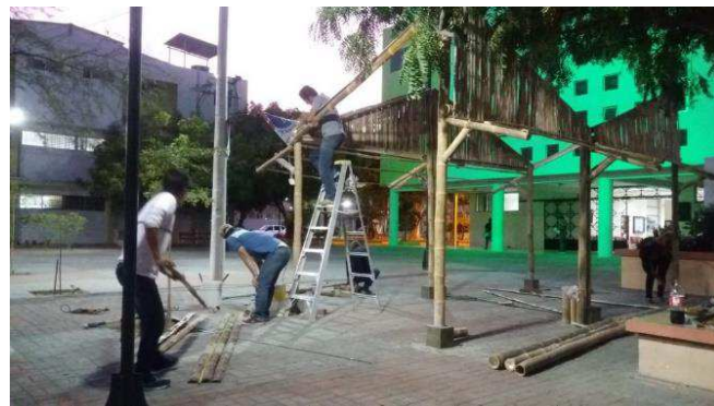
Figura 28: Colocación de correas para cubierta de lona. Fuente: Elaboración propia.
