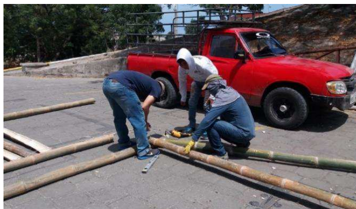
Figura 21: Armado de módulo. Fuente: Elaboración propia.
