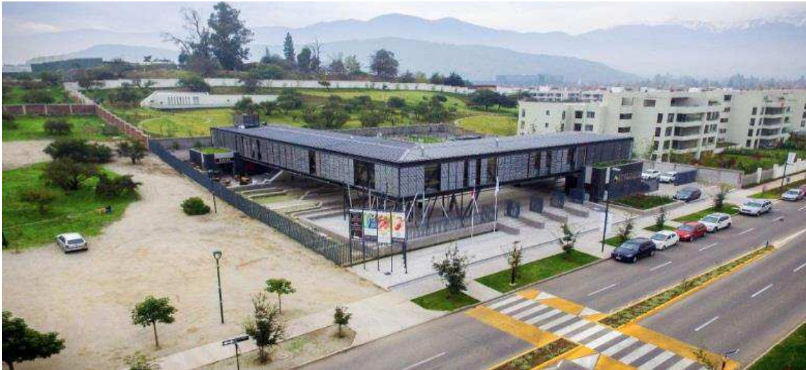
Ilustración 4. Edificación general y entorno Fuente: www.plataformadearquitectura.cl
