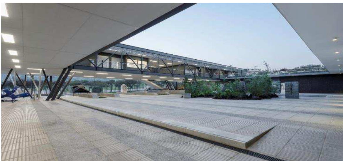
Ilustración 5. Vista de plaza interior Fuente: www.plataformadearquitectura.cl
