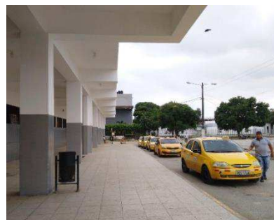
Fotografía: Parte Interior.
