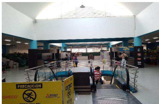
Fotografía: Planta alta. Fuente: tomado por tesista.
