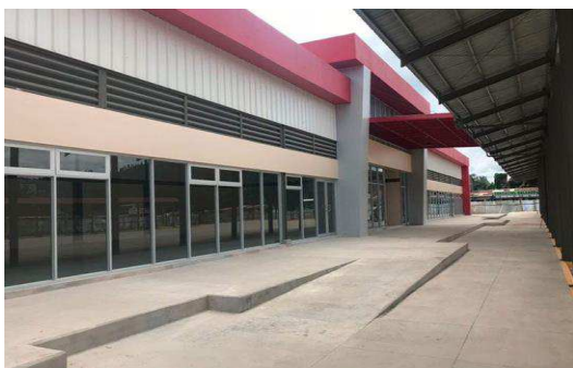
Fotografía: Avances de la obra. Fuente: latribuna.hn
