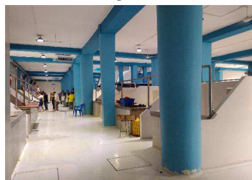
Fotografía: pasillos - planta baja. Fuente: tomado por tesista
