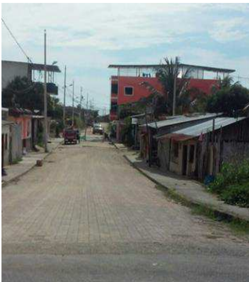
Grafico 36: Capa de rodadura – colectoras.
